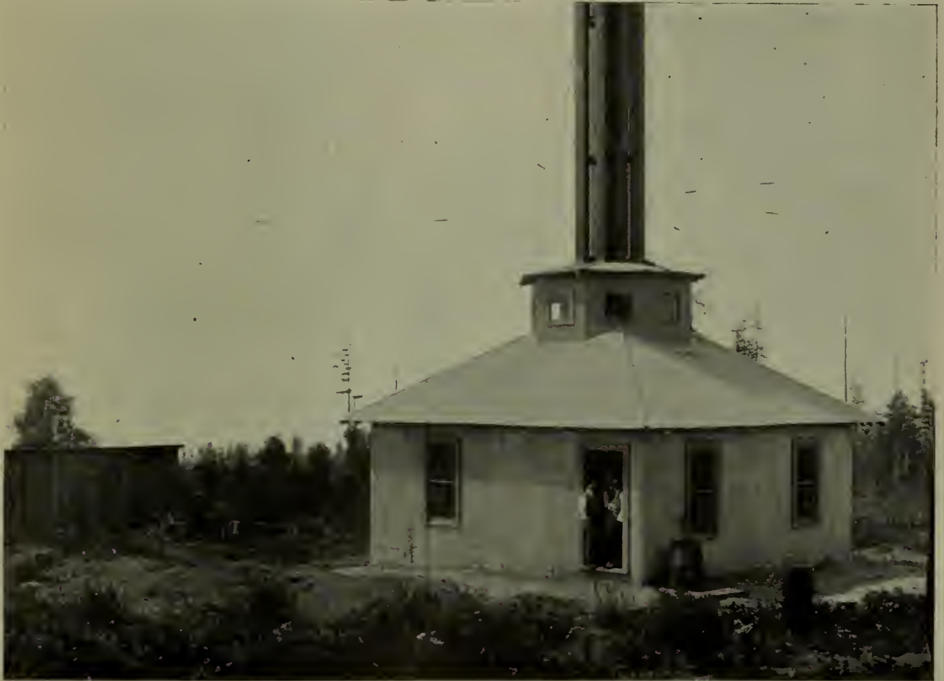
Fig. 290. — Vue du poste et de l'installation génératrice.
